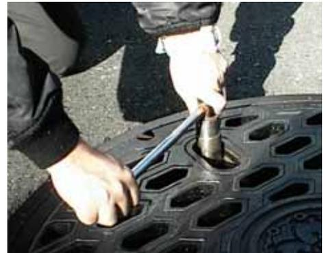
全箇所ボルトが締め上がったら、ゴムカバーをはめ込む。
