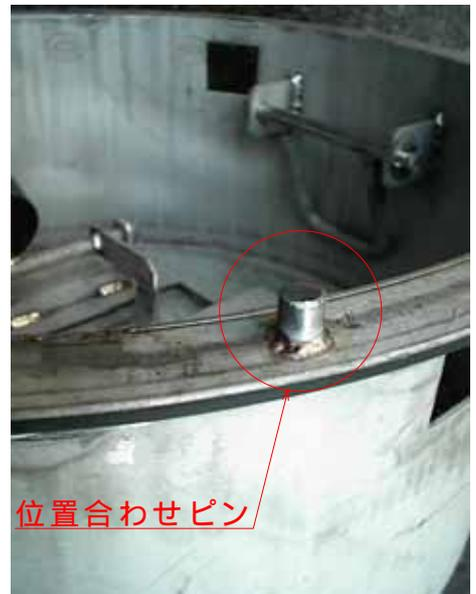
蓋のロック装置（クランプ）のボルトを緩め蓋の中心側にずらし空気弁筐の位置合わせピンに蓋のGLVマーク左のこじり穴がくるように蓋の向きを合わせてセットする。
