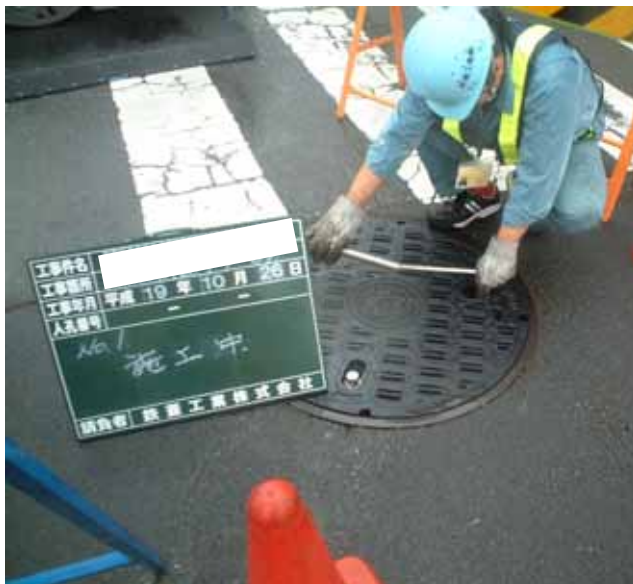
No.1施工中(ボルト締め)
